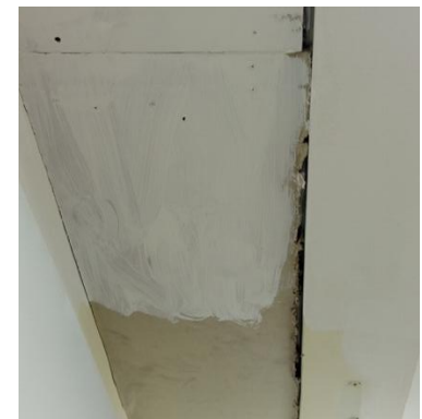
CIELORRASO CON AFECTACION DE HUMEDAD
